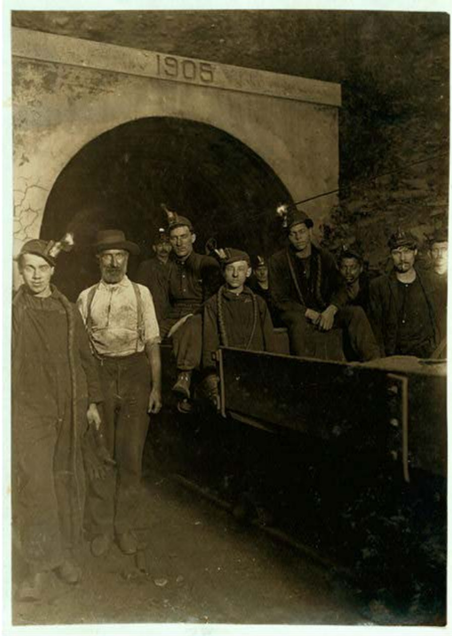
Entrée principale, mine Gary en Virginie de l'ouest. Plongeurs et mineurs allant au travail à 7 h. du matin et restant sous-sol jusqu'à 17h30.
